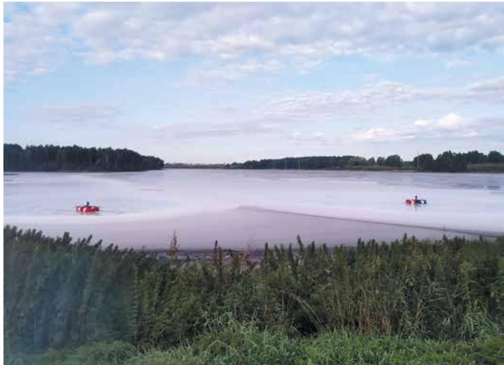
хучих газов (таких, как сероводород и аммиак) и ускоряют процесс ее переработки. В этом им помогают аэраторы — установки, которые перемешивают жидкость и вносят кислород, чтобы «правильные» микроорганизмы могли «дышать».
